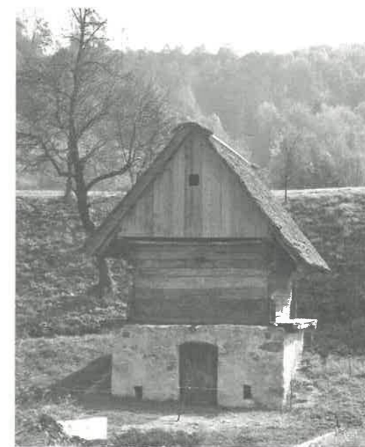
Bizjakova "klet" (kašča) na Humu iz leta 1714, značilna lesena stavba s slamnato streho nad pozidano. Foto: Silvester Gaberšček 1997, fototeka Tolminskega muzeja.
