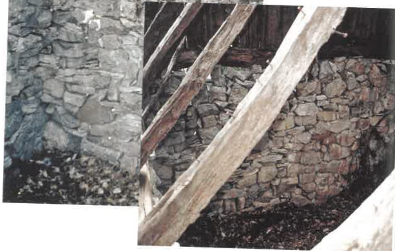
Maticov senik nad Zadlazon Čadrgom, primer "halštatske" gradnje suhega zidu in ostrejša "na škarje". Foto: Silvester Gaberšček 1998, fototeka Tolminskega muzeja.
