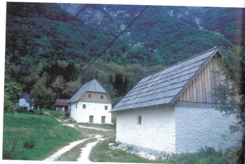
Lepena, domačija Pri Matevžu, popotresna obnova (nadomestna gradnja).
