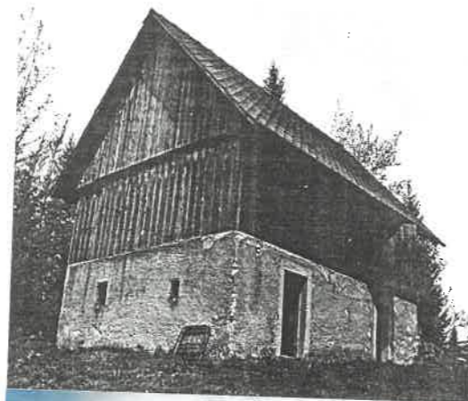
Gorjuše – rekonstrukcija in sprememba namembnosti nekdanjega kmetijskega gospodarskega poslopja.
