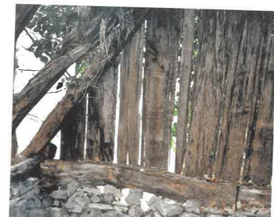
Maticov senik nad Zadlazon Čadrgom, primer "halštatske" gradnje suhega zidu in ostrejša "na škarje". Foto: Silvester Gaberšček 1998, fototeka Tolminskega muzeja.
