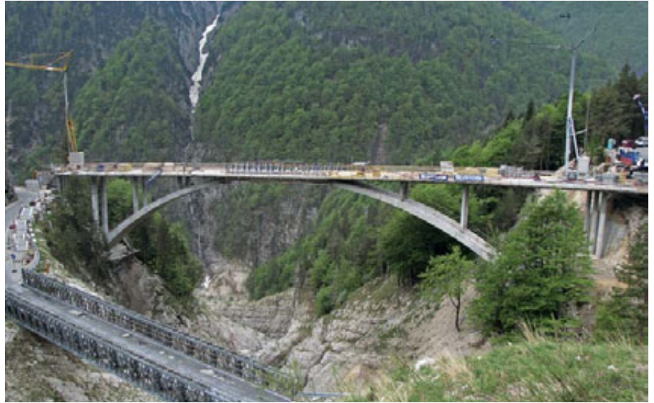
Gradnja v času izvedbe voziščne konstrukcije viadukta
