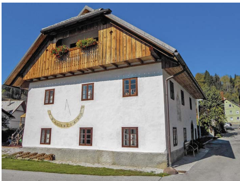
FASADNO OKRASJE (KAMNIT VHODNI PORTAL, FRESKA SV. FLORJANA IN SONČNA URA) IN ZATREPNI GANK NA KAJŽNKOVI HIŠI V RATEČAH
