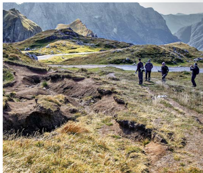
STANJE PRED SANACIJO
