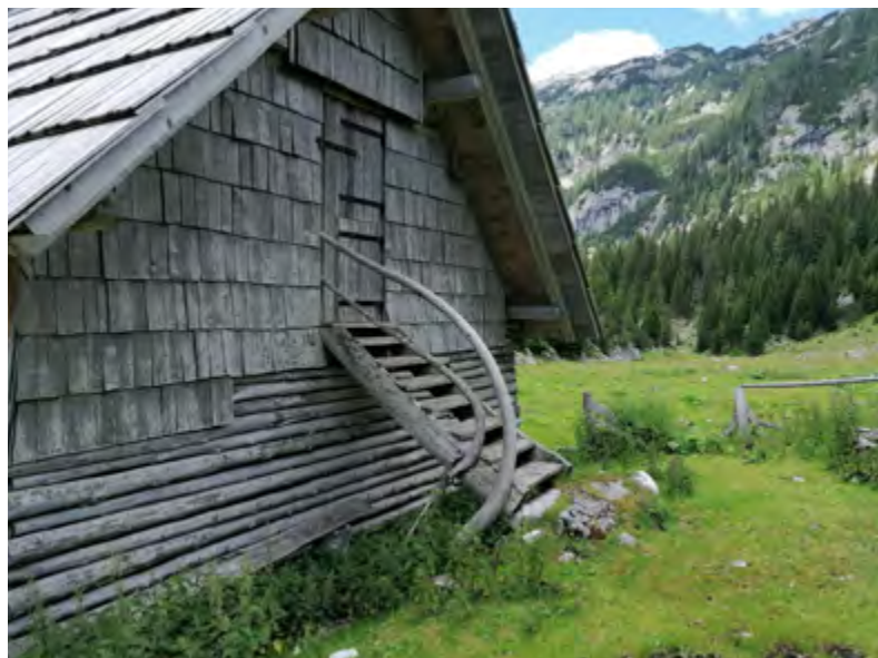
Razlikovanje v podrobnostih zrcali izvorno in sprotno prilagajanje stopnic zahtevani višinski razliki in uporabnosti prostorov. Planina Dedno polje (zgoraj). Planina Laz (spodaj). Planina Zajavornik (desno).
