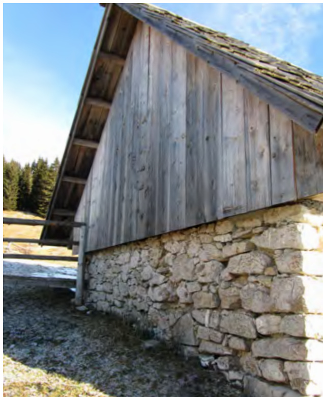
Kamnit zidan podstavek je neravnemu terenu izvrstno prilagojen z različnimi višinami. Planina Zajamniki, hlev (Vir: Delavnica FA in TNP)
