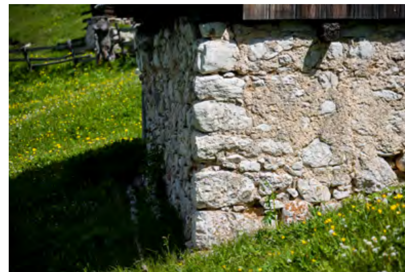
Videz kamnitih sten, izdelanih iz neobdelanih ter gobo obdelanih naravnih kamnov. (Vir: Deu, 2018, str. 84) (Planina Praprotnica in Planina Zajamniki)
