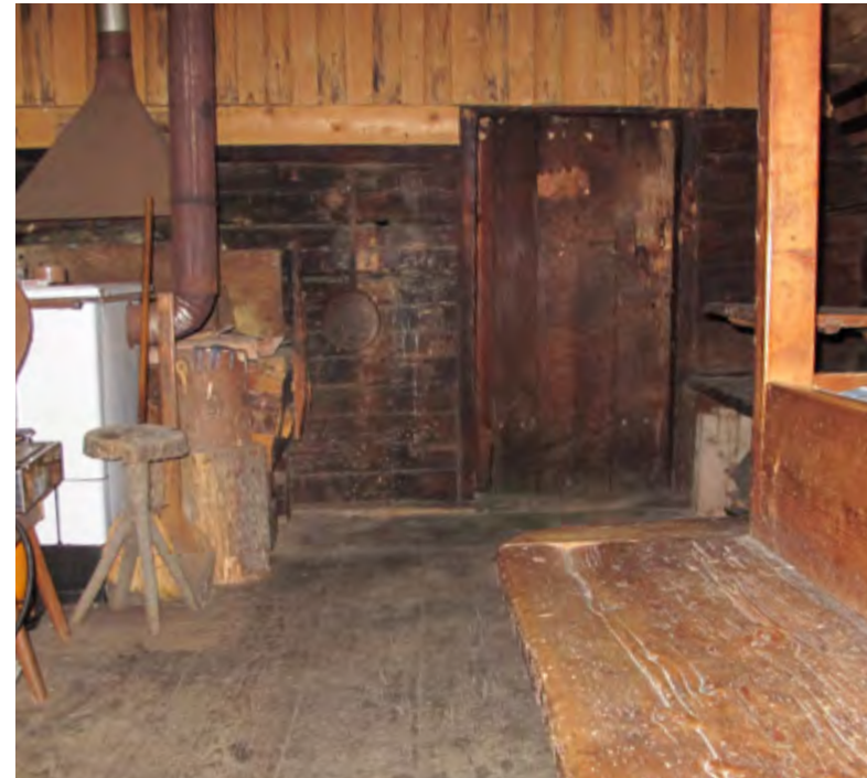
Pogled v notranjost bivalnega prostora, dvignjenega na odprto podnožje. Tlak oblikujejo široke in z oblanjem zglajene in zravnane deske. Planina Zajavornik
