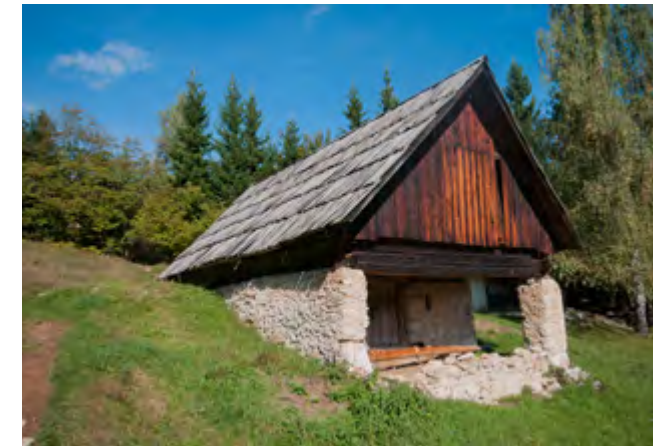
Višina kamnitega podnožja je prilagojena zemljišču, gradnja iz kamna pa je enaka gradnji kamnitih zidov pri zidanih oziroma delno zidanih delno lesenih objektih. Planina Vogar , hlev
