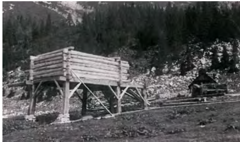
Pastirski stan na lesenem podnožju, na šestih lesenih »kobilah«. »Pastirski stan v bohinjskih planinah so gradili najmanj po štirje možje; kočo so postavili v približno enem mesecu, če so morali posekati tudi les«. Planina Laz, stan (Vir: Cevc, 1984, str. 46)
