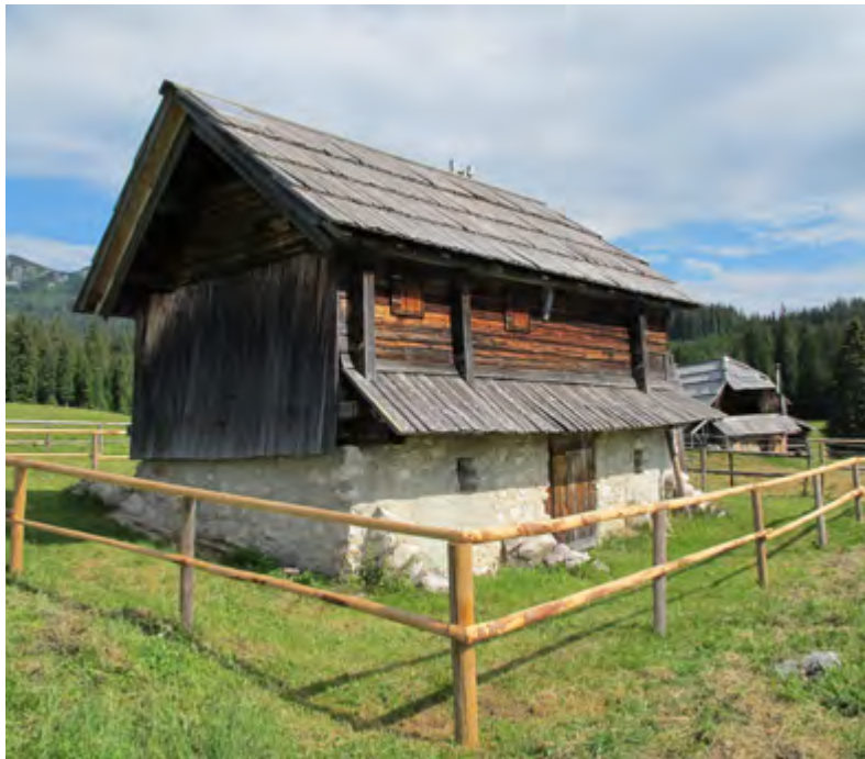
Lesen stan z zidanim podnožjem ima čelno stran lesenega masivnega ovoja, izdelan je iz štiristransko obdelanih klad, pred neugodnim vremenom – dežjem in snegom z vetrom – dodatno zaščiteno z opažem iz desk v naklonu (odtekanje vode). Prav tako ima z deskami zaščitene križne vezi - čela tramov. Planina Zajavornik
