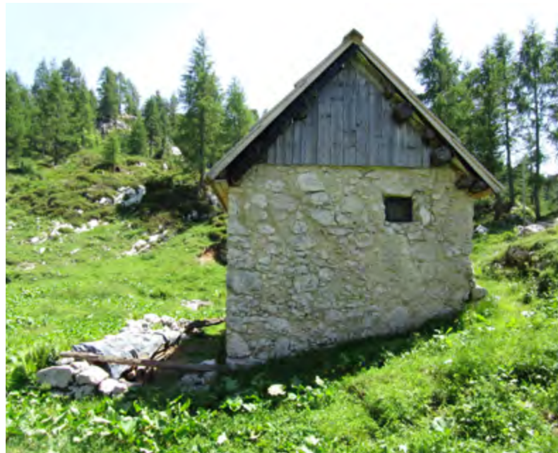
Del zunanjega ovoja tvorijo kamnite stene, izdelane z malto iz grobo obdelanega naravnega kamna. Planina Ovčarija
