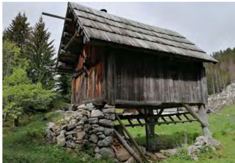
Podnožje stanu je sestavljeno iz kamnitega opornega zidu in lesenih stebrov. Nadgradnja, bivališče pastirja, je lesena. Planina Vodični vrh, stan
