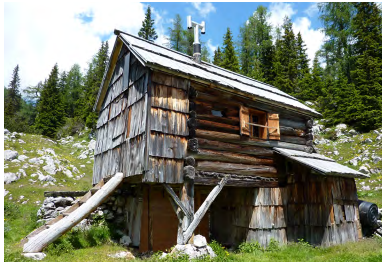
Podstat, na kateri stoji stan, sestavljata kamnito obodno zidovje in ena kobila. Planina Dedno polje
