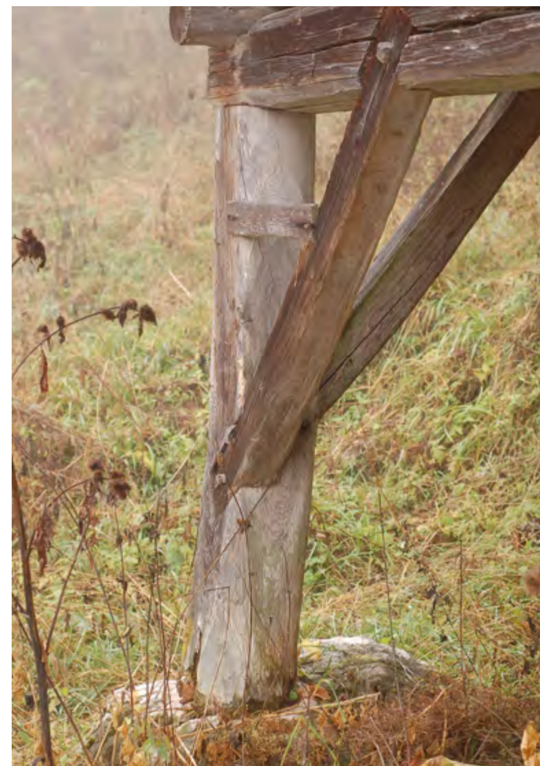
Kobila je »poldrugi meter visok lesen stebri s kamnitim podstavkom, sestavni del ogrodja pastirske kočice (Bohinj)«. (Slovenski etnološki leksikon, 2011, str. 220) Planina Grintovica, stan
