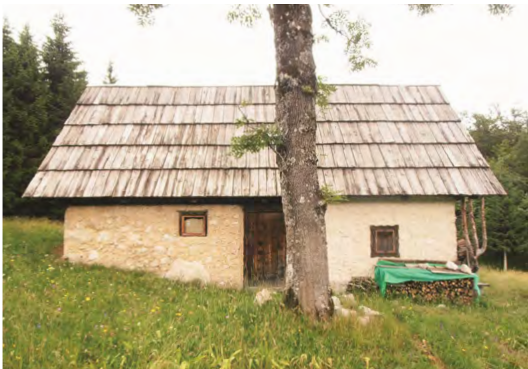
Primer kamnitega podstavka s kamnito nadgradnjo – kamniti zidovi. Planina Vogar
