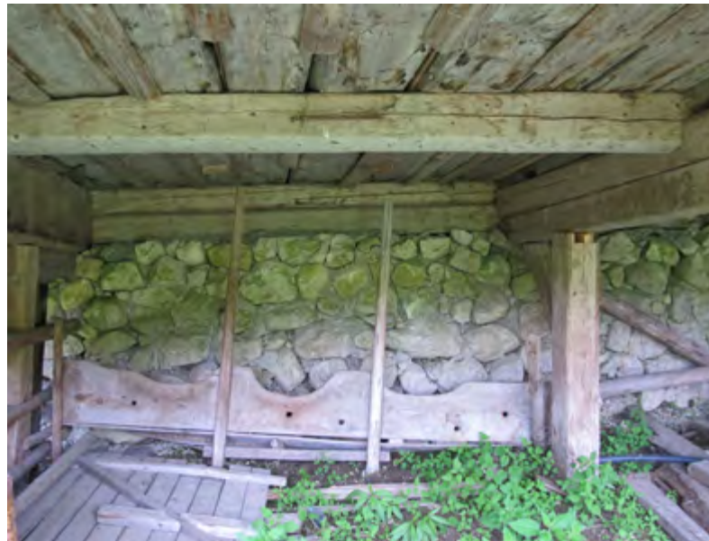
Pogled na strop grobo obdelane elemente konstrukcije, ki sestavljajo strop nad delno zaprtim zatočiščem za živino. Planina Zajavornik
