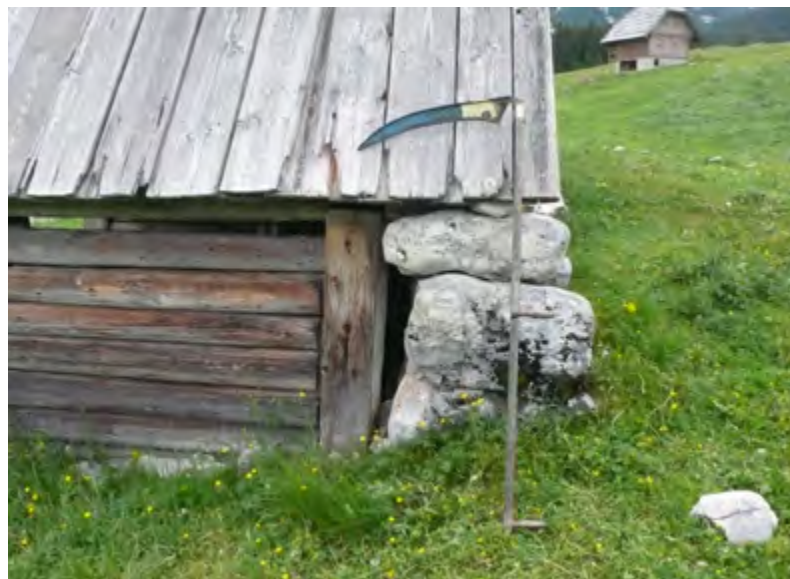
Polovična bruna, elementi lesene stene, so v vogalih vpeta v pokončne stebre. Planina Zajavornik, hlev
