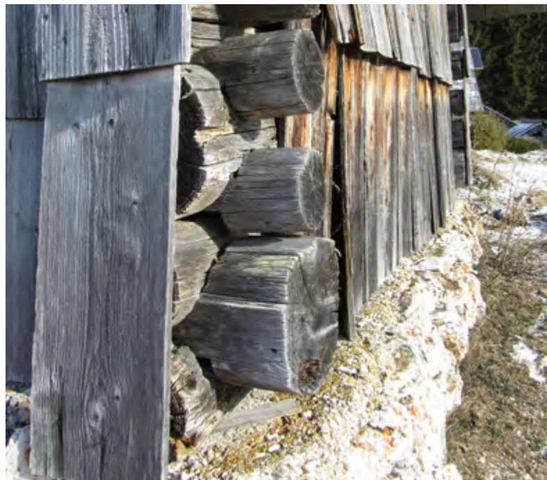
Pri kladnih stenah, posebej, če je konstrukcija položena le na nizek kamnit podstavek, pazijo, »da je oklep spodnjih brun debelejši in to zaradi mokrote«. Planina Zajavniki (Cevc, 1984, str. 66).
