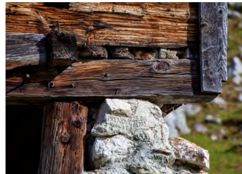
Pogleda na del zunanje stene z vidno »stropno ploščo« – na »podsek« položenimi plohi – podnicami. Planina Laz
