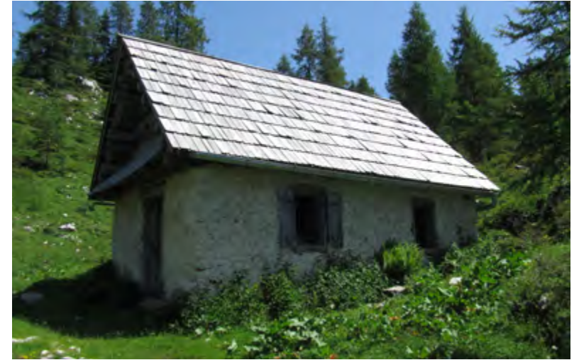
Polkna so izdelana iz gladkih, zglajenih desk, ki so med seboj zvezana tako kot enako izdelana vratna krila iz pokončno postavljenih in prečnimi letvami zvezanih desk. Planina Ovčarija
