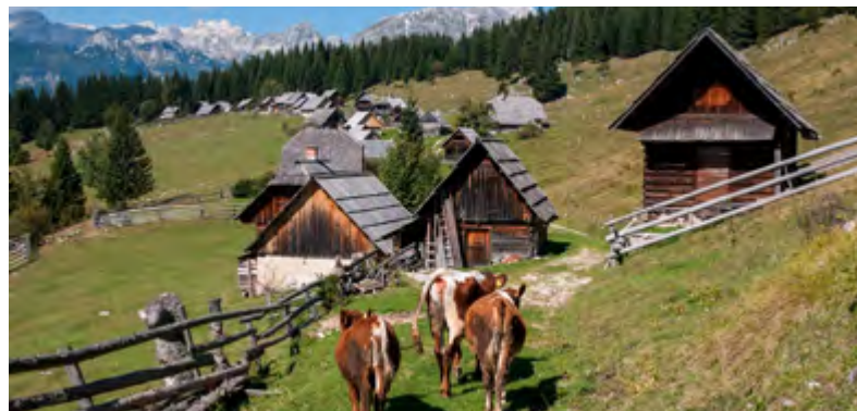
Dovršena konstrukcija stavb v planinskih naseljih odstira gozdarska, tesarska, zidarska in mizarska znanja, ki so se z zvezno gradnjo v zahtevnih, naravnih okoljih, z uporabo naravnih, avtohtonih gradiv, izpilila do popolnosti. Planina Zajamniki
