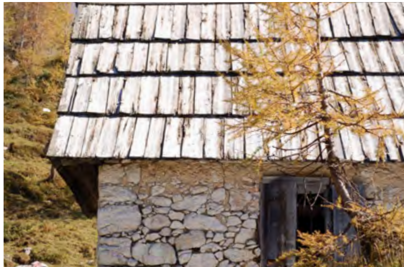
Ovoj iz kamnitega zidu iz neobdelanega lomljenca je utrjen z apneno malto in vogalnimi vezmi, kamnoseško obdelanimi večjimi kamni. Planina Ovčarija, sirarna
