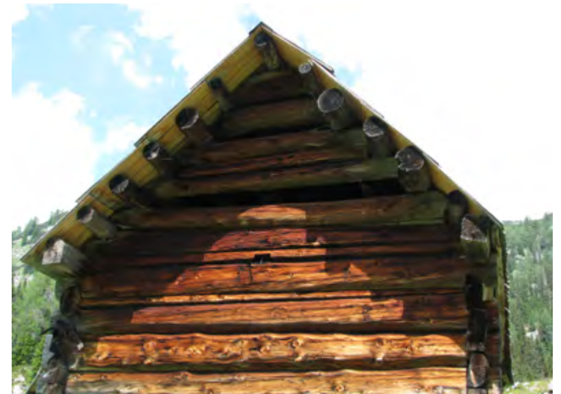
Prikaz značilne in identitetne konstrukcije ostrešja z legami – »na kašto«, brez in s čopom. Planina Dedno polje (Vir: Delavnica FA in TNP)
