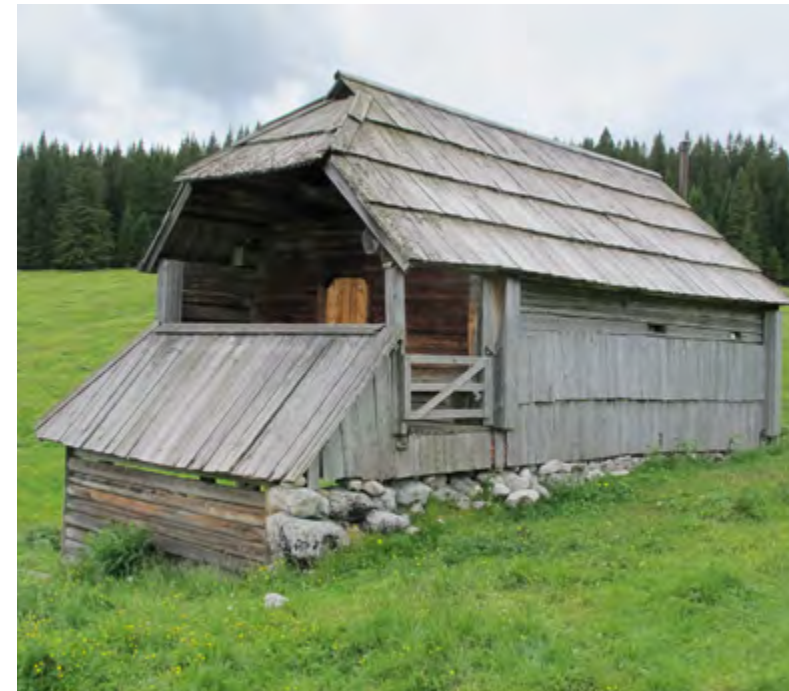
Vzdolžno leseno masivno steno, izdelana je iz vodoravno naloženih tramov, ščiti opaž, ki je izdelan iz krajših desk, ki so na (pod)konstrukcijo pritrjene s prekrivanjem – odtekanje vode. Planina Zajavornik
