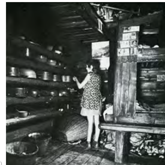
Pogled v notranjost bivalnega prostora, dvignjenega na odprto podnožje. Tlak oblikujejo široke in z oblanjem zglajene in zravnane deske. Planina Zajavornik
