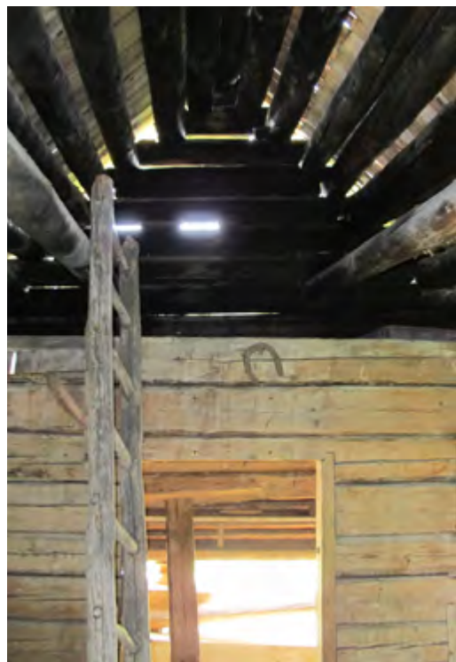
Lege so vpete v čelno steno izdelano iz različno obdelanih klad. Planina Zajavornik, hlev in Planina Goreljek, stan .
