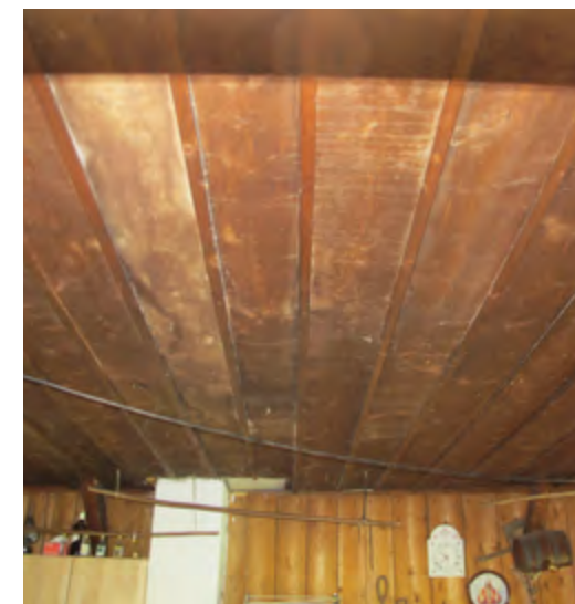
Pogled na strop – navaden lesen tramovni strop, ki ima želje po kar se da lepem izgledu, sestavne dele konstrukcije skrbno tesarsko obdelane. Planina Zajavornik
