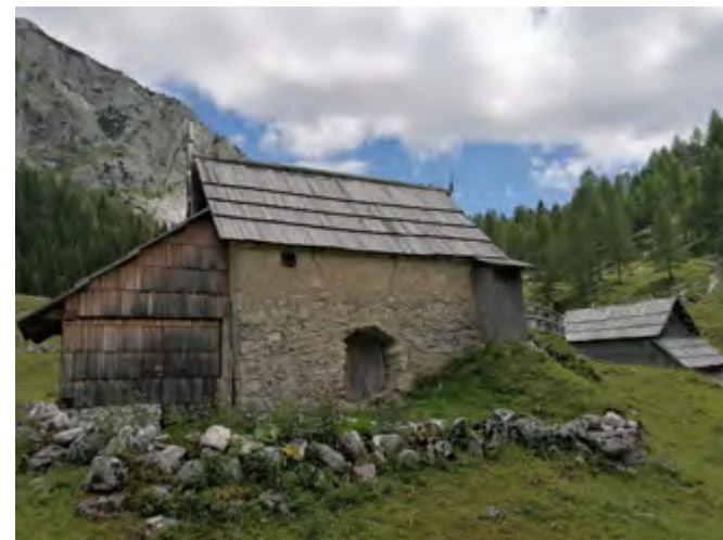
Kamnito podnožje ali podstavek, zgrajeno iz neobdelanega in grobo obdelanega naravnega kamna, se nadaljuje v kamniti zid. Planina Laz , stan
