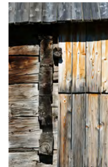
Vzori različno oblikovanih masivnih kladnih sten: stena iz brun (fotografija 1), stena iz polovičnih brun (fotografija 2), stena iz tramov (fotografija 3) in stena iz plohov (fotografija 4).
