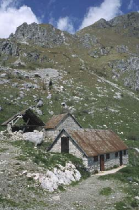
Slеме - ob potresu poškodovani objekti
